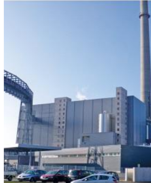
RHKW Linz (2012) 76 MW 275,000 t/a
